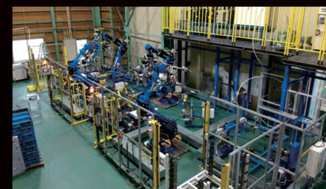
量産用スポットロボット設備
